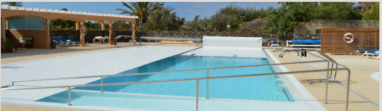
CUBIERTA AUTOMATICA DE LAMAS DE PVC 25 x 12.50 | CENTRO SVENKA (GRAN CANARIA)
